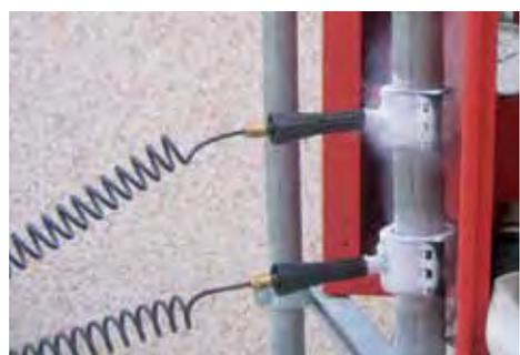
Il kit consente di congelare tutti i tipi di liquidi, inclusi quelli ad alta pressione, all'interno di tubazioni in acciaio, rame, alluminio o plastica.
